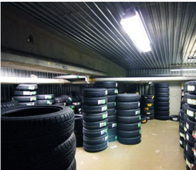
Så här ska det se ut, med gott om utrymme mellan lysrör och däck för att minska risken för brand.
