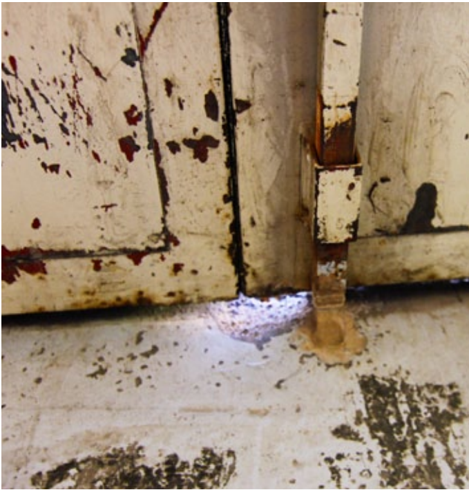
Spanjoletten som spänner fast dörren i taket och golvet gör djupa urgröpningar i betongen. Ett rejält plattjärn runt hålet stoppar dörren från att bli slapp.
