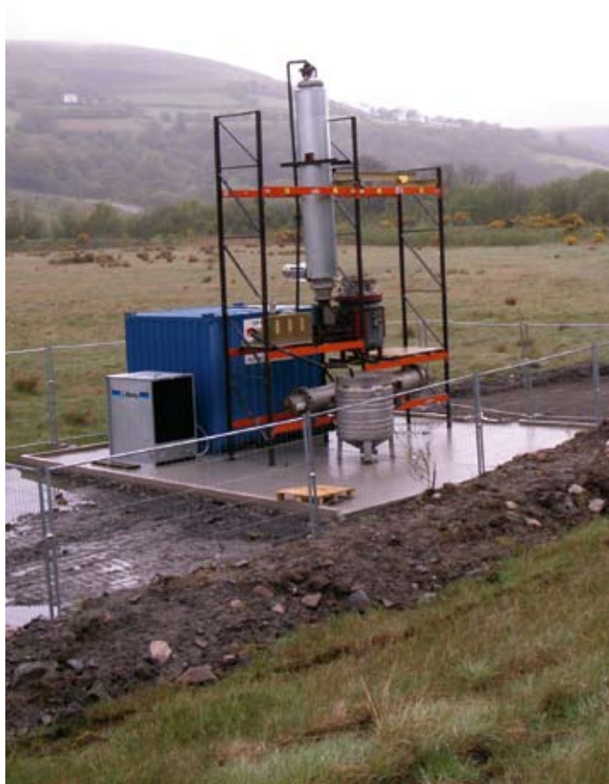
Pilotanläggningar finns i Sverige, USA och Storbritannien. Bilden visar pilotanläggningen i Skellefteå.
