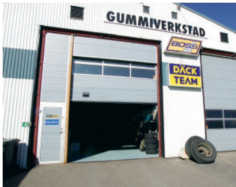
Även utomhus har däckverkstaden renoverats med nytt tak och nymålad entré.
